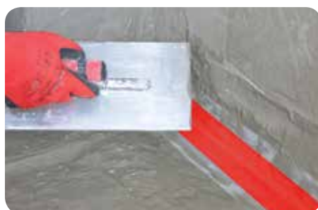
Κάλυψη των γωνιών με ελαστικές ταινίες
