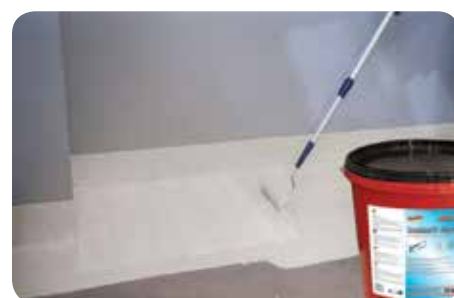
Εφαρμογή του Izoelastic Liquid
